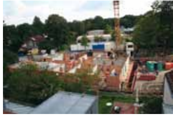
Neubau im Sommer 2006
